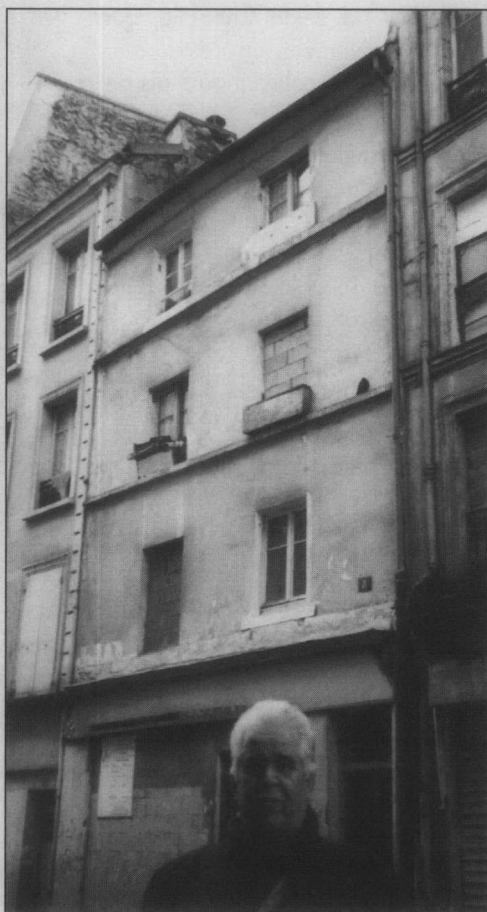
M. Zaïd devant l'hôtel avant sa démolition
