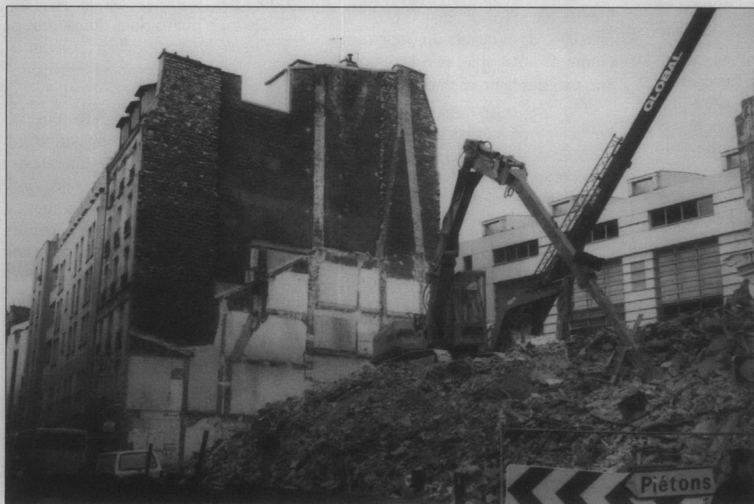
Démolition des immeubles 20 à 28 rue de Chartres
