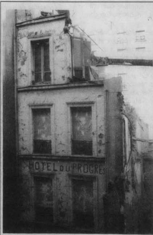
La démolition de l'HÔTEL DU PROGRES (rue de Chartres) : un symbole qui disparaît...
