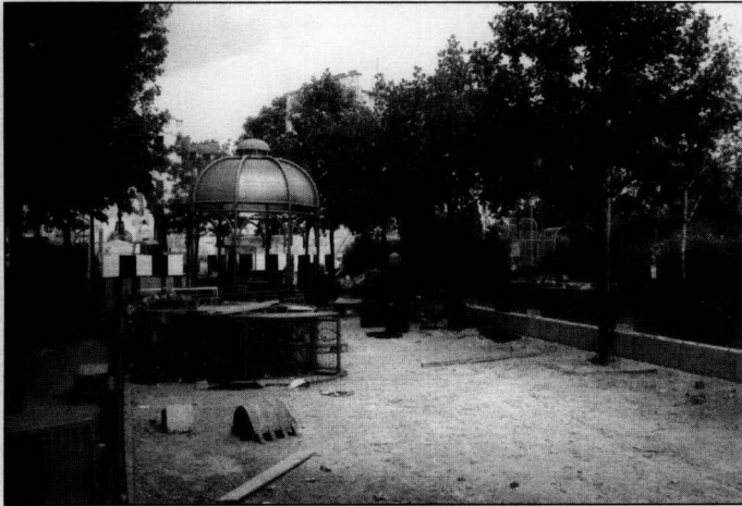
La nouvelle clôture en construction Square Léon (côté Polonceau)
