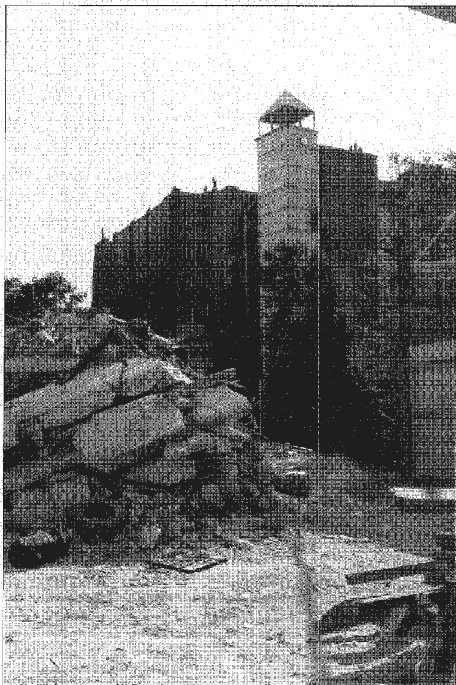
En haut et à droite : le 52 rue de la Goutte d'Or durant sa démolition
