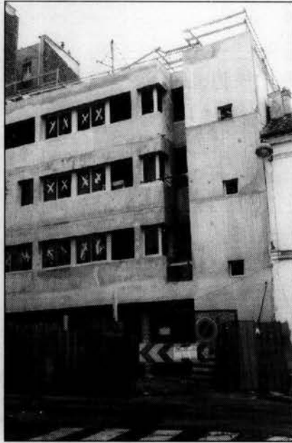
Le Pôle Santé du 16/18 Cavé en construction
