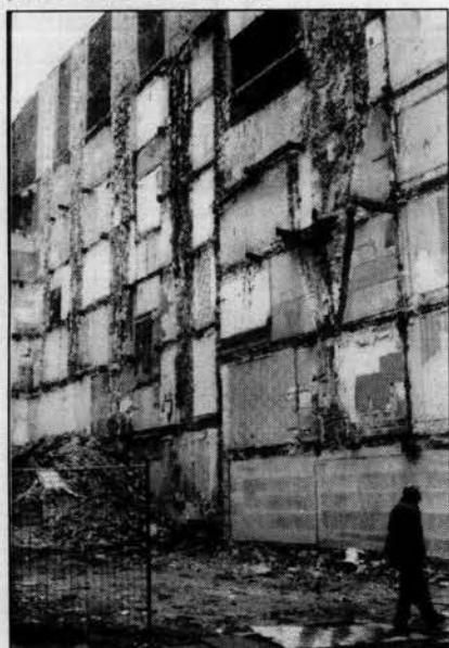
Mur est du 52 Goutte d'Or après démolition
