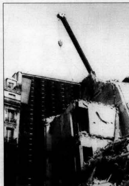
La démolition du 51 Goutte d'Or
