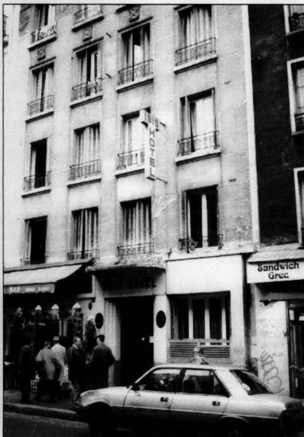
L'hôtel Ibis qui devrait être bientôt démolit
