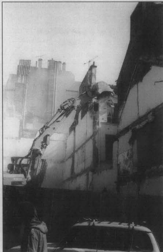
La grue à l'œuvre à l'angle Polonceau/Poissonniers
