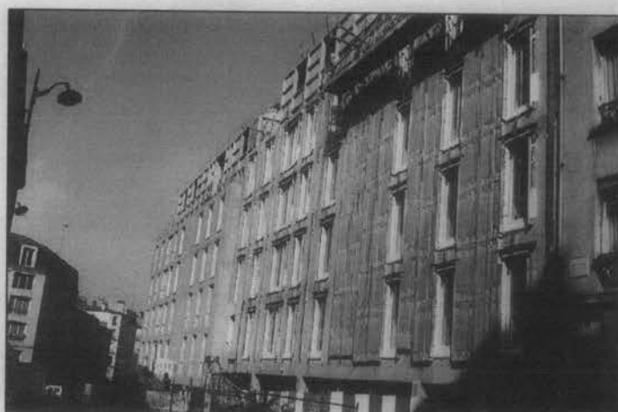
Le square Saint-Bernard en cours de réaménagement
