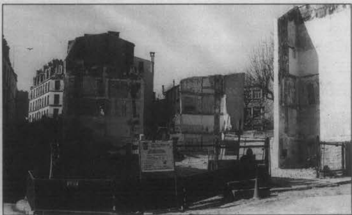
L'angle Gardes/Polonceau après démolition
