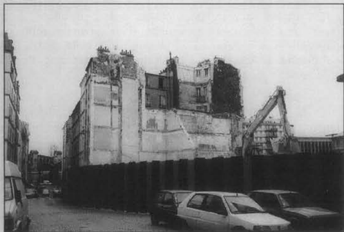
13 rue de Chartres après démolition
