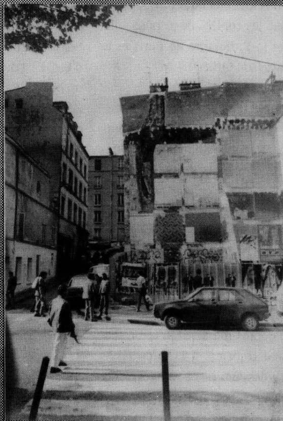
Ci-dessus: l'ancien poste de police (72-74 Chapelle) détruit. A gauche: le 40 Goutte d'Or muré depuis plusieurs années. Page 2 en haut: le 28 Charbonnière muré depuis plus de 5 ans. Page 2 en bas: l'emplacement du 56-58 Chapelle loué à la Pub...
